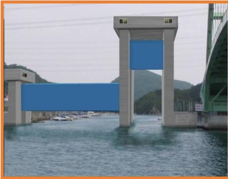
(設置例：海底設置型フラップゲート式水門)
