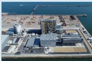
■ バイオマス発電プラント
