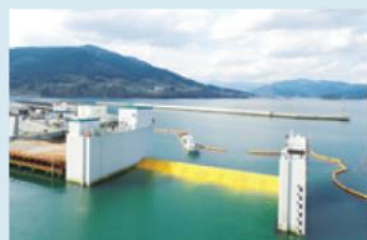
■ 海底設置型フラップゲート式水害対策設備
