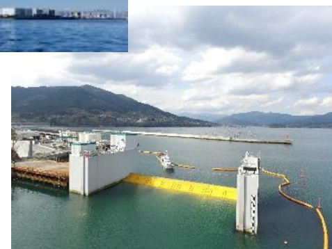
フラップゲート式可動防波堤
