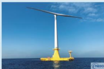
■ 風力発電 (NEDO次世代浮体式洋上風力発電システム実証研究(パーシブ型))
