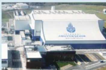
■ ゴミ焼却発電施設
