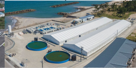
陸上養殖施設(水処理システム)
