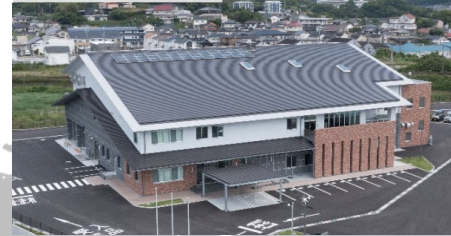
汚泥再生施設
