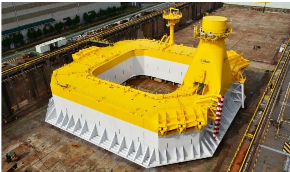
図1 完成した次世代浮体式洋上風力発電システムのバージ型浮体
