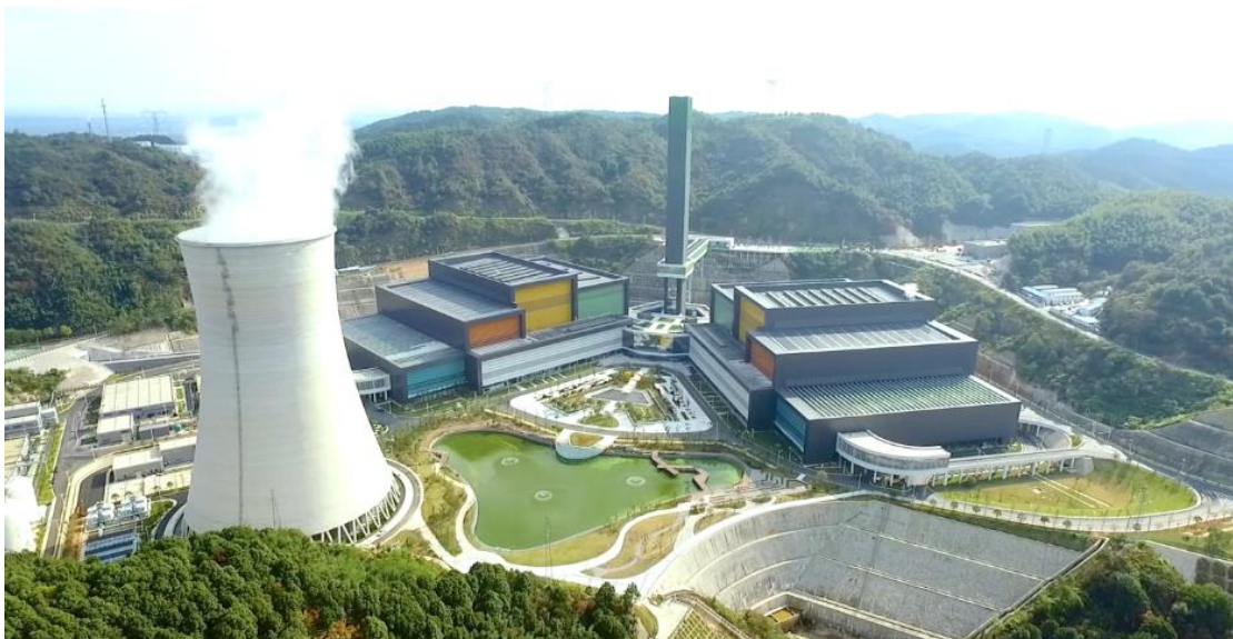
1期プラント外観
