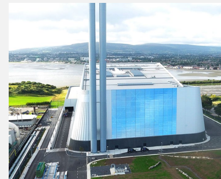
ダブリンWaste to Energyプラント
