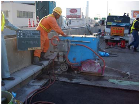
1 カッター切断
