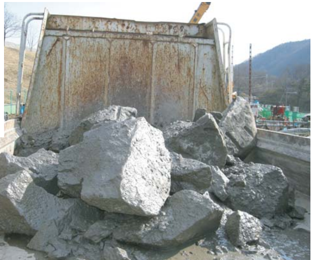
掘削ズリ搬出
