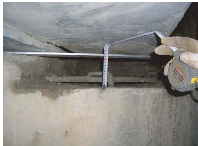
⑥ 施工完了
