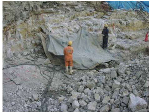
3 防音・防爆シート設置
