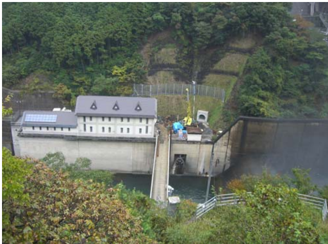
狭隘な施工条件
