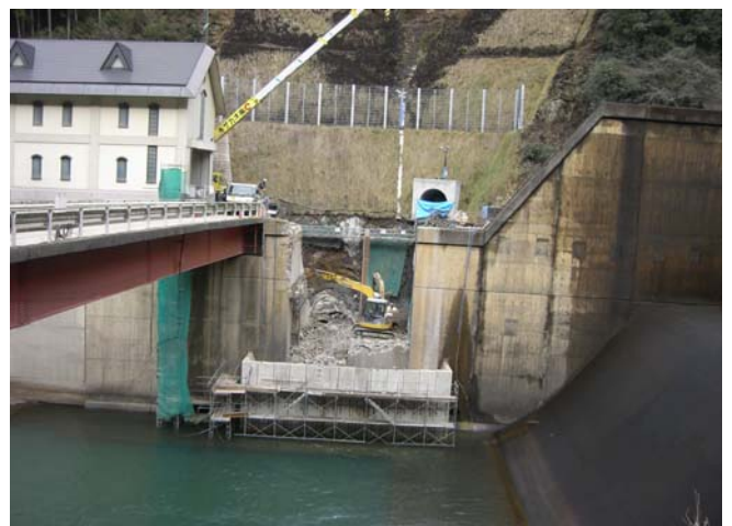
厳密な施工管理
